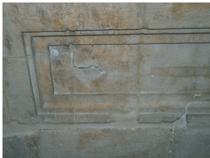
15. Il consolidamento del paramento murario dell'architrave centrale è stato realizzato con l'inserimento di barre in acciaio inox di cui nella foto si vede una terminazione chiusa da un bullone e verniciata del colore della pietra.
