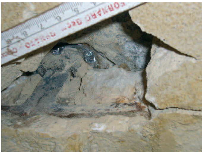
14. L'immagine mostra una delle staffe metalliche a T, piombata nella parte superiore, che sostengono il paramento murario decorato dell'intradosso dell'architrave centrale.
