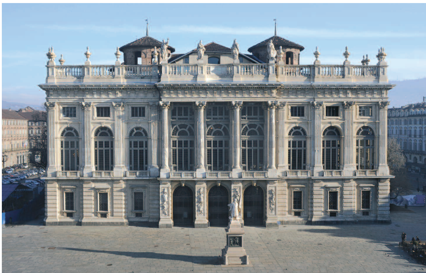
19. Veduta d'insieme della facciata dopo il restauro.
