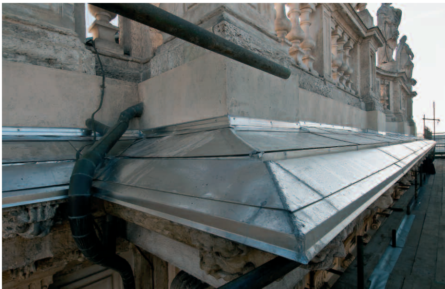
11. Il cornicione come appare dopo il restauro. Il foglio di zinco è stato sovrapposto al piombo originale.
