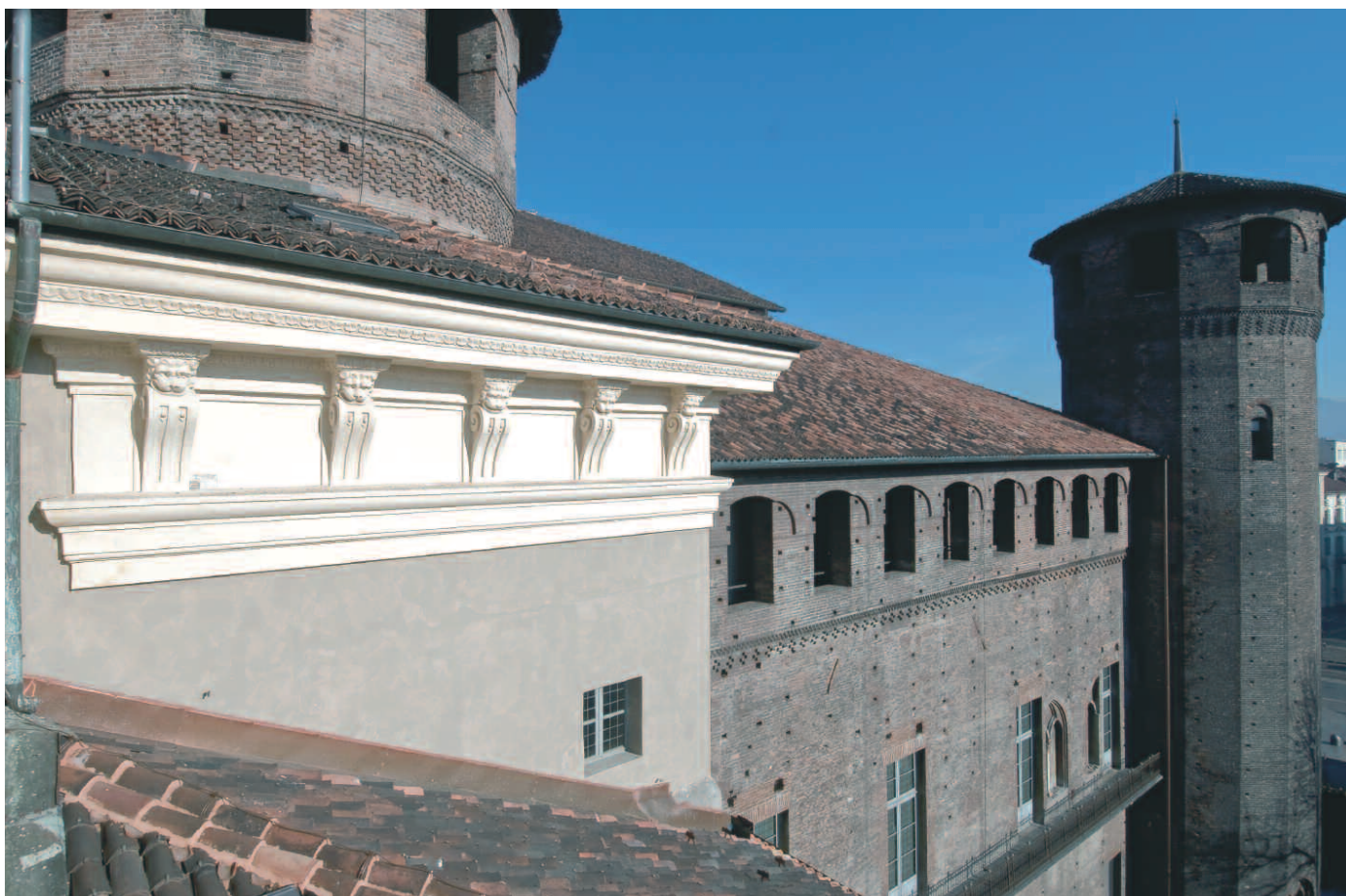
9. Veduta del lato sud di Palazzo Madama con il cornicione dei leoni. Si intravedono i saggi di scoprimento degli intonaci cinque-seicenteschi.
