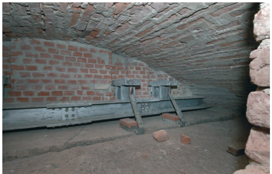
13. La camera interna dell'architrave centrale con la struttura di sostegno realizzata nel 1998, allacciata verso il basso a uno dei monoliti in pietra di Borgone.
