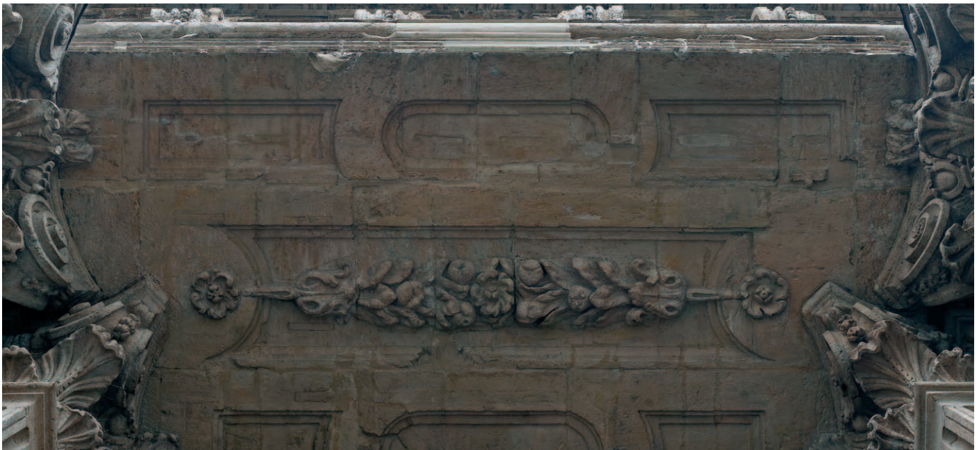
12. Veduta d'insieme dell'intradosso dell'architrave centrale dopo il restauro. La decorazione è costituita da lastre di marmo di Chianocco scolpite a riquadri e festoni.
